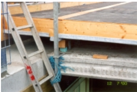
Foto 1: Elementer monteret på betondæk på Hotel
